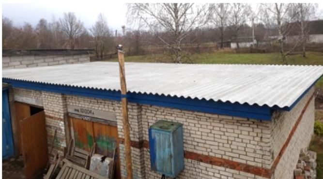
Material für die Dacheindeckung des Schulnebengebäudes, in dem auch der Schulbus untergebracht ist
